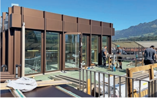
Fassadenarbeiten Attikageschoss Gemeindehaus
