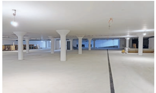
Malerarbeiten Parking Untergeschoss
