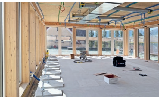
Innenausbau Attikageschoss Gemeindehaus
