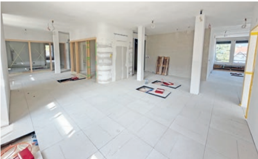
Innenausbau Bürozonon Gemeindehaus
