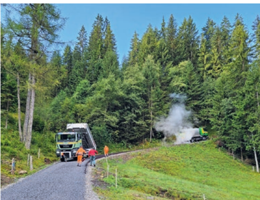
Oberflächenbehandlung auf der Strasse Witenmattboden-Teufibach
