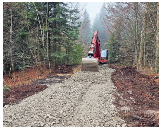
Ausbau Erschliessung Enetriederwald
