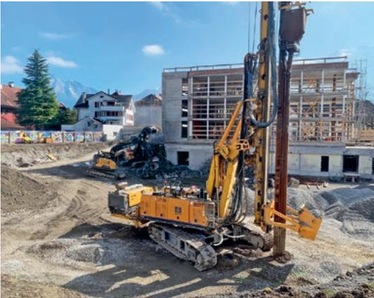
Bohrarbeiten der sogenannten Rüttelstopfsäulen
