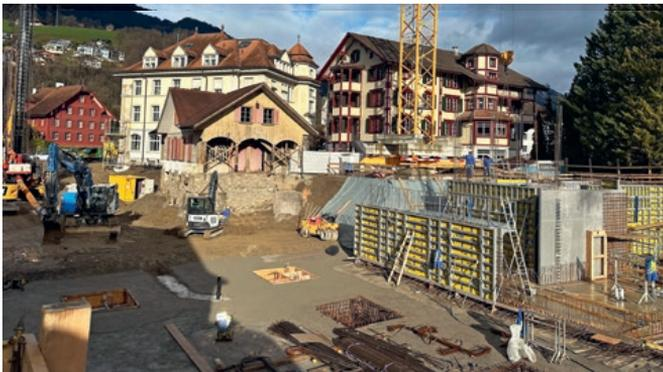
Die Betonpfähle sind versetzt und Teile der Bodenplatte fertig betoniert. Die ersten Seitenwände sind ebenfalls hochgezogen.
