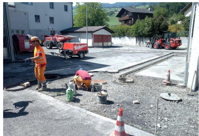
Werkhof Wolfgrube: Baufachmann beim Sanieren des Belags
