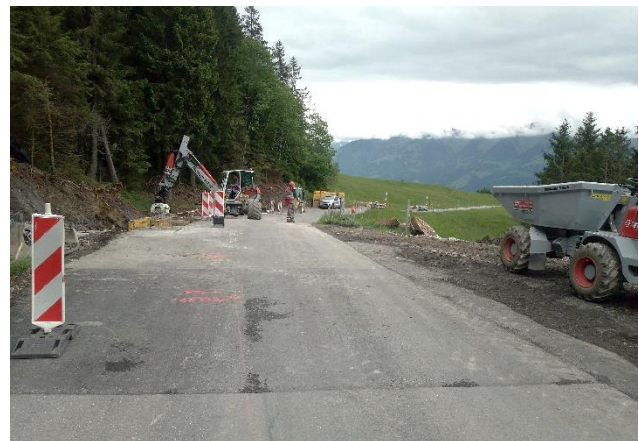
Bauarbeiten im Bereich Schwandmettlen
