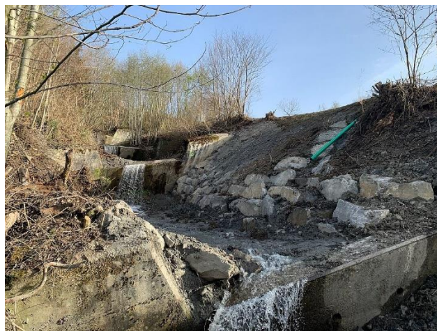
Sperre und Böschung gesichert
