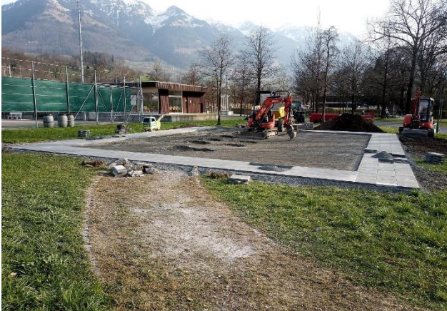
Street Workout Park während des Neubaus
