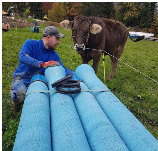
Ramersberg: Vorbereitung und Kontrolle der Rohre vor dem Verlegen
