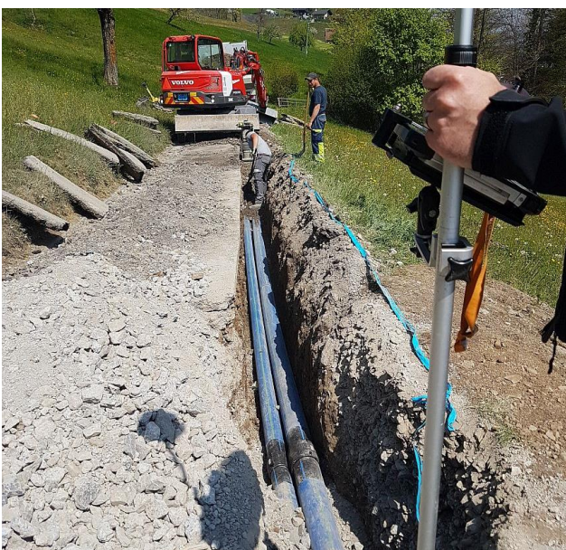
Giglenstrasse: Leitungen verlegen und einmessen
