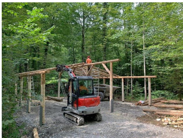
Der neue Unterstand wird aufgerichtet
