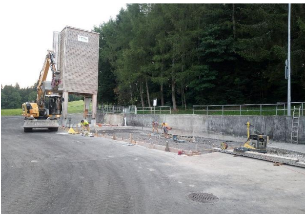
Werkhof Wolfgrube: Baufachleute beim Erstellen der Bodenplatte
