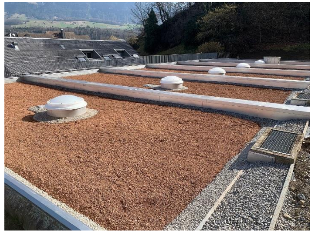
Neu saniertes Flachdach mit extensivem Begrünungsaufbau
