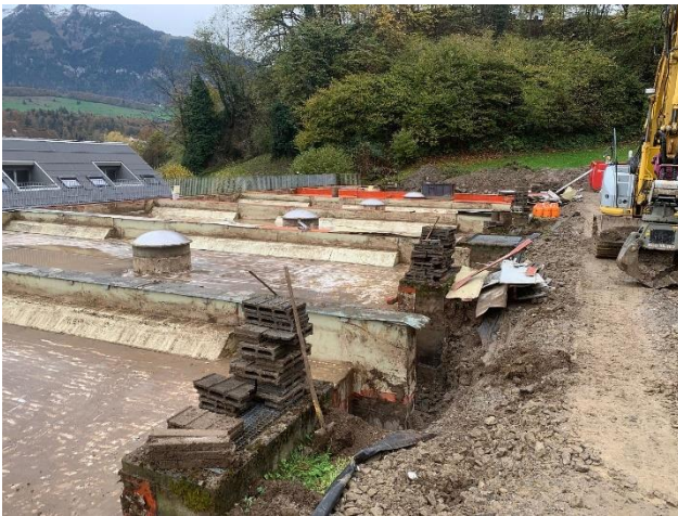
Alte Flachdachabdichtung während des Rückbaus
