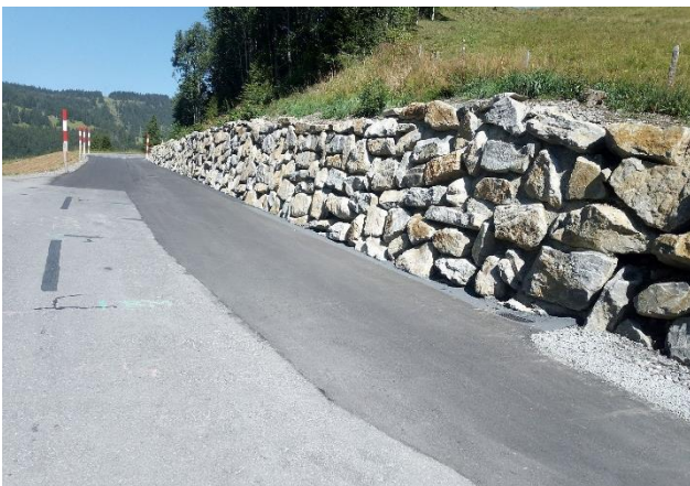
Neu gebaute Stützmauer entlang der Glaubenbergstrasse
