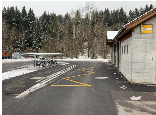
Hindernisfreie Bushaltestelle Stalden-Sportplatz
