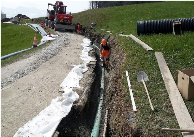
Giglenstrasse: Neubau einer Sickerleitung
