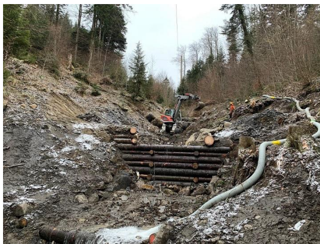
Ersatz der Holzschwelle durch eine doppelwandige Holzkastensperre
