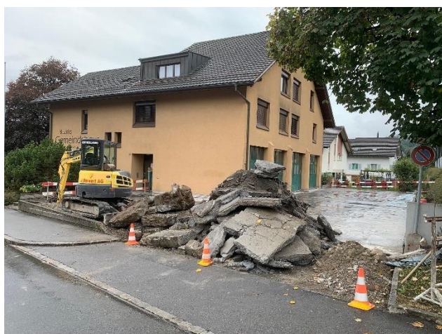
Rückbau des undichten Flachdachaufbaus
