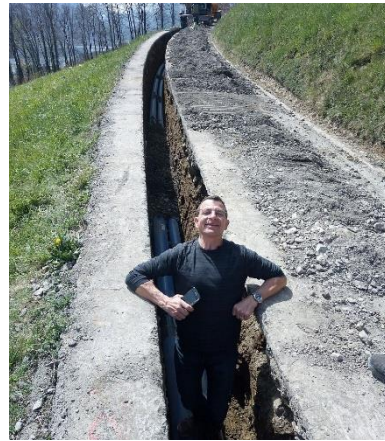
Giglenstrasse: Kontrolle Wasserleitung
