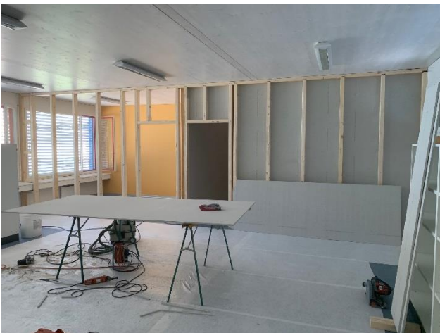
Umbaumassnahmen im ehemaligen Kindergarten-Pavillon
