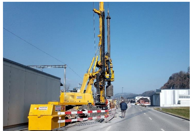
Pumpenwerk Kernmatt: Pfahlbohrmaschine
