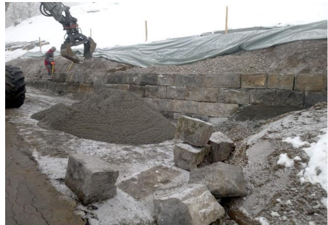
Hintergrabenstrasse Ramersberg: Neubau Ausweichstelle
