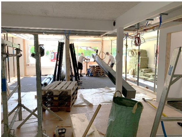
Umbauarbeiten im OKB-Provisorium
