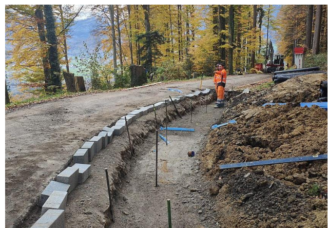
Feldmoswald: Baufachleute beim Versetzen von Randsteinen
