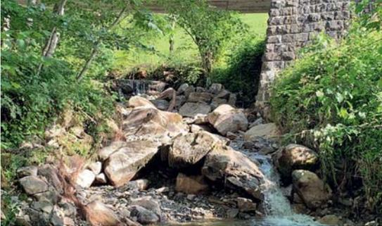
Hintergrabenbrücke: unterspültes Brückenfundament
