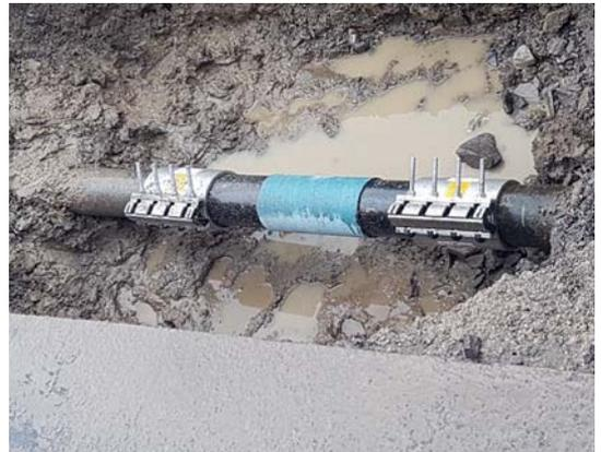
Reparierte Hauptwasserleitung: Ersatz von einem Meter Rohr mit zwei Reparaturschellen
