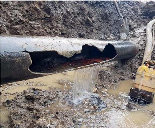
Freilegen des Rohrbruchs und vorbereiten der Reparatur
