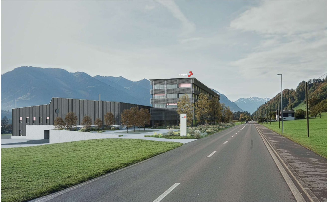
Abb. 2: Ansicht von Norden (Warenanlieferung Hangar und Verwaltungsgebäude)
