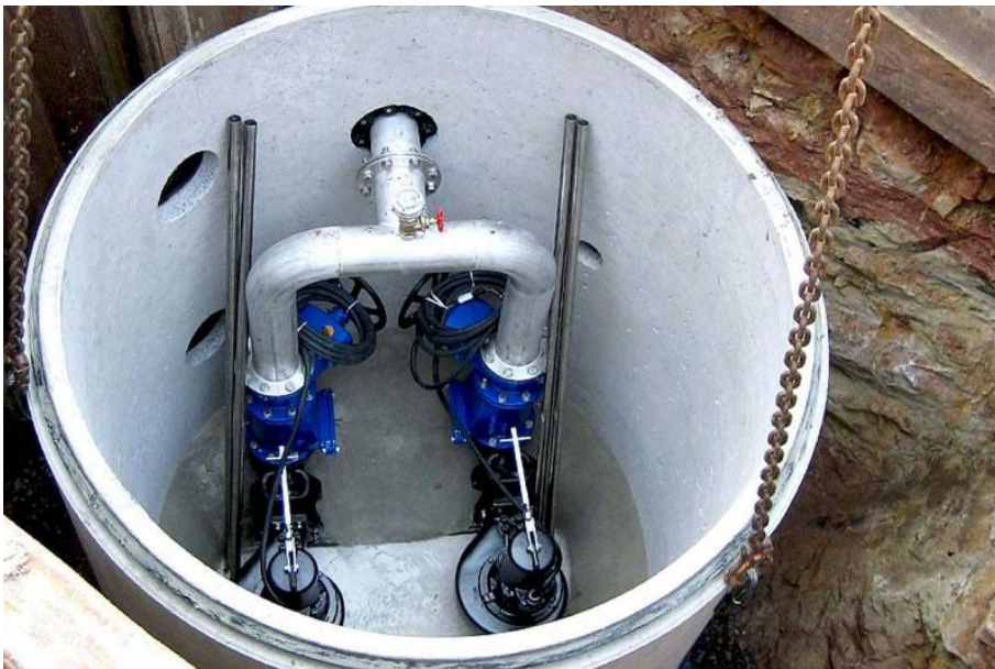
Abbildung 4-1: Beispiel Pumpenschacht mit Doppel-Pumpensystem während Einbau (Quelle: www.finger-beton.de )
