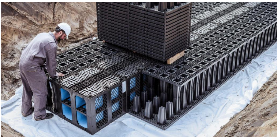
Abbildung 5-2: Beispiel für eine unterirdische Retention mittels Kunststoffboxen [14]
