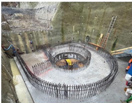
12. Februar 2026: Bewehrung auf Bodenplatte für Drallkammer (Wirbelfall)
