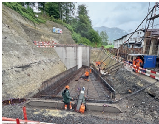
6. Mai 2026: Bewehrung Zulaufkanal
