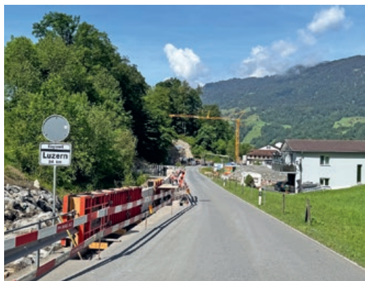
21. Mai 2026: letzte Betonieretappe Leitmauer entlang Kägiswilerstrasse
