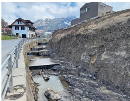
1. April 2026: Gerinneverbreiterung entlang Kägiswilerstrasse fertig erstellt
