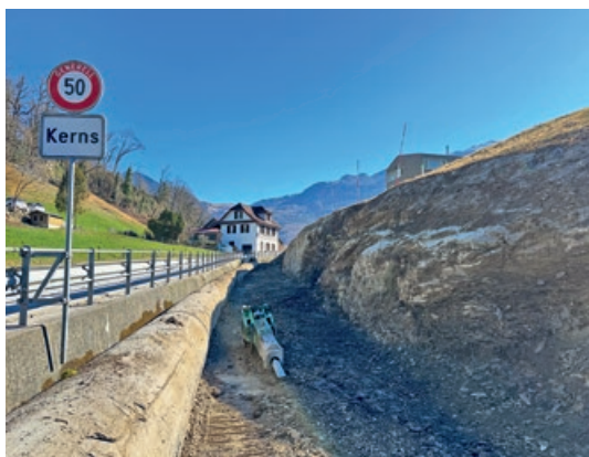
27. Februar 2026: Gerinneverbreiterung entlang Kägiswilerstrasse
