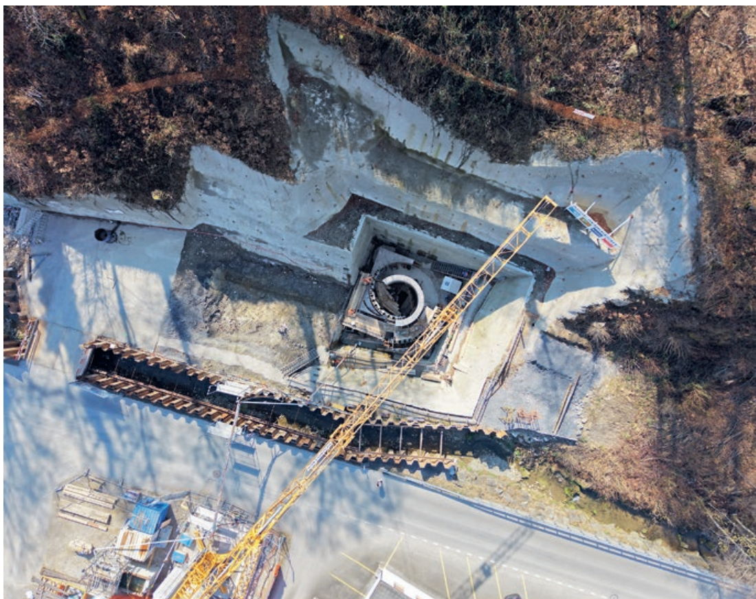
20. März 2026: Baufortschritt HWS Kernmattbach aus der Vogelperspektive
