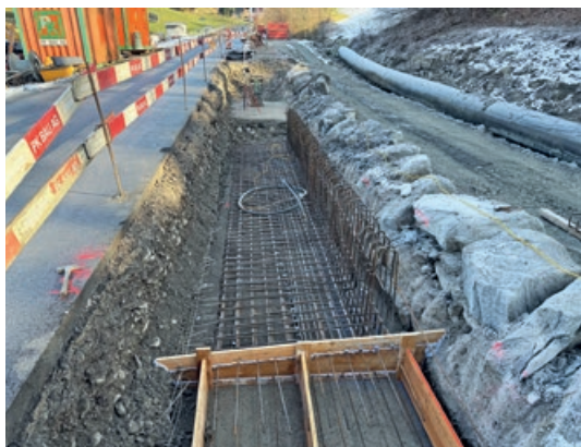
21. Januar 2026: Bewehrung Fundament Leitmauer entlang Kägiswilerstrasse
