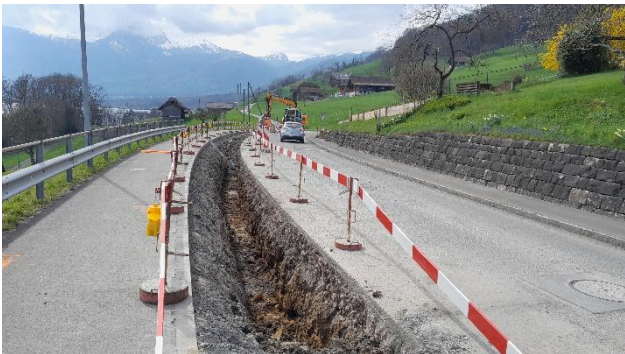
Ersatz der Wasserleitung in der Wilerstrasse
