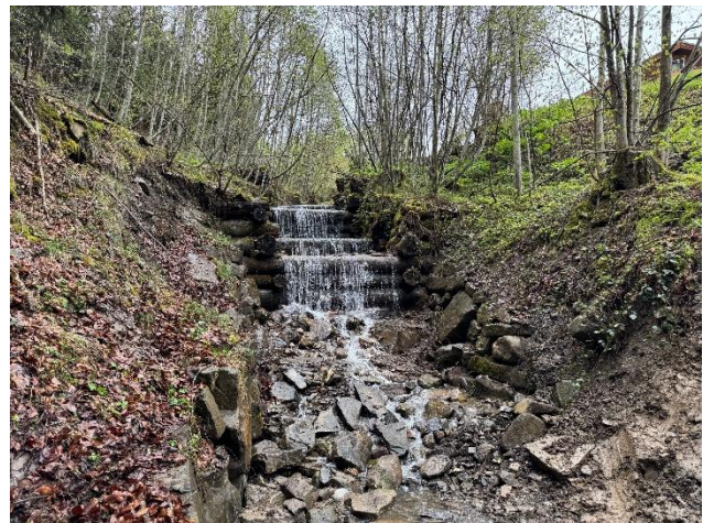
Schlimbach: Holzsperrre neu verfüllt und gesichert
