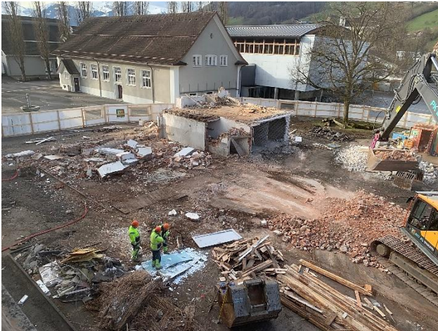
Rückbau Schulhaus 4 und Baugrubenaushub
