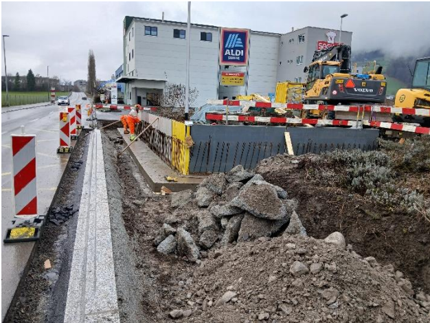
Hindernisfreie Bushaltestelle Ried Fahrrichtung Sarnen
