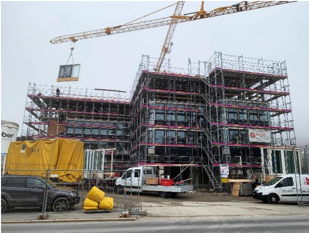
Einbau Fensterelemente im Gemeindehaus
