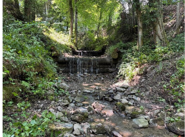
Steinhaltengraben: Holzsperrre neu verfüllt
