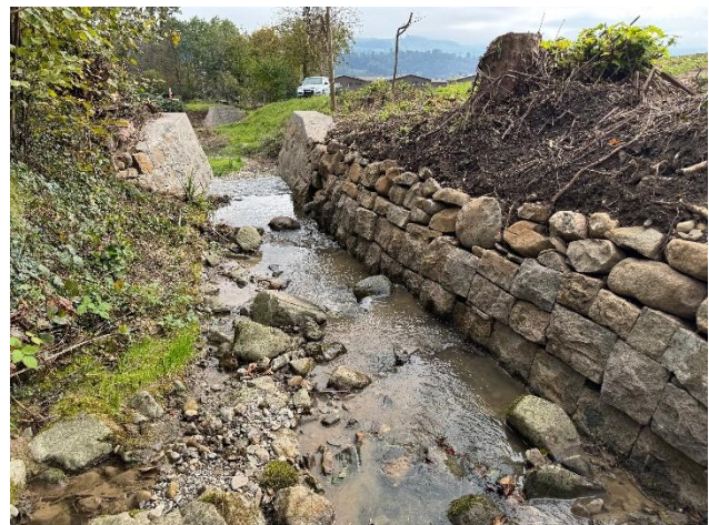
Chli Schlierli: Trockensteinmauer bei Sammlereinlauf freigelegt
