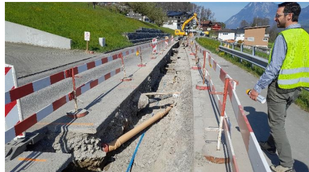
Ersatz der Wasserleitung in der Wilerstrasse
