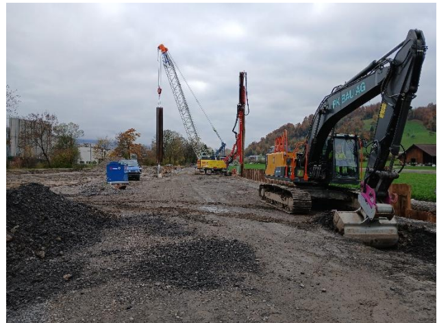
Installationsplatz, Maschinen beim Einbau von Spundwänden
