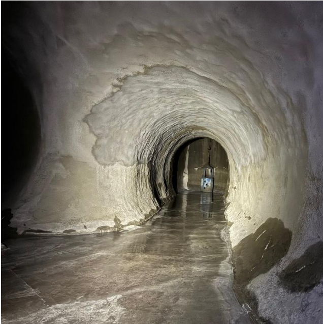
Kernmattbach: Fertiger Verbindungsstollen mit Blick zum Wirbelfallschacht
