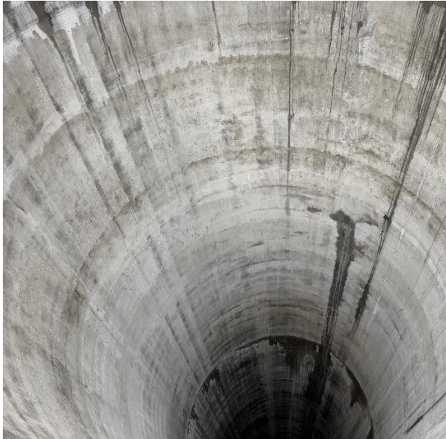
Kernmattbach: Fertig ausbetonierte Schachtwand
