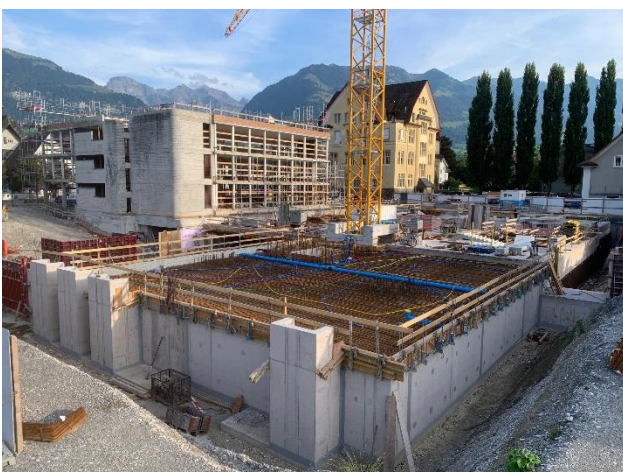
Fertigstellung Rohbauarbeiten Tiefgarage
