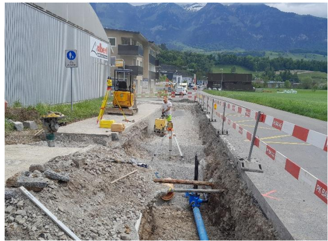
Bauarbeiten für die Tellenstrasse im Bereich der Bahnhofstrasse
