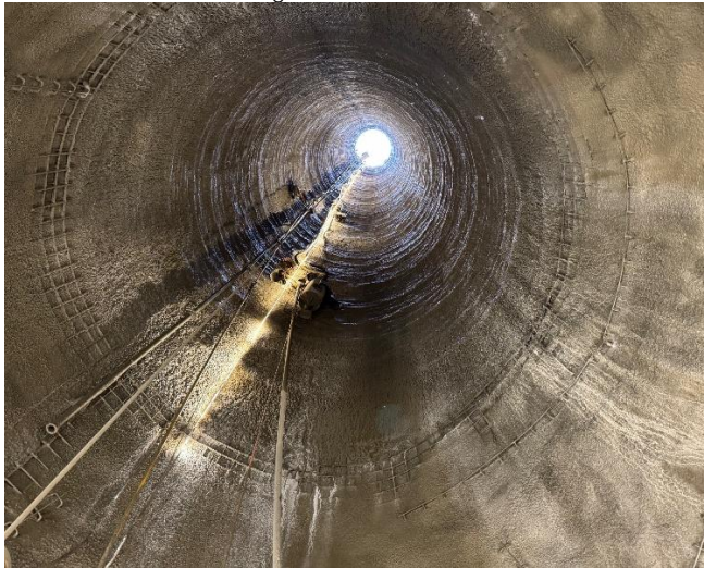
Kernmattbach: Blick vom Schachtfuss ans Tageslicht
