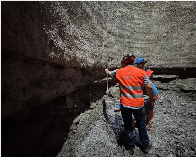
Kernmattbach: Masskontrolle in 57 m Tiefe
