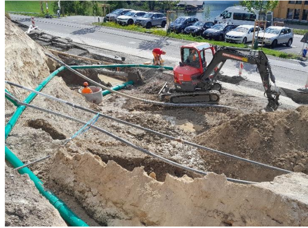
Leitungsgewirr beim Aushub der neuen Bushaltestelle
