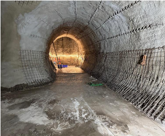
Kernmattbach: Blick vom Stollen Ost durch den Verbindungsstollen
