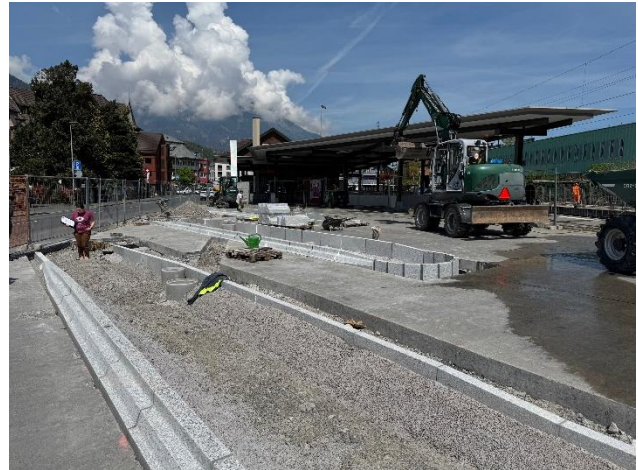
Umbau Haltestellen beim Bahnhof Sarnen
