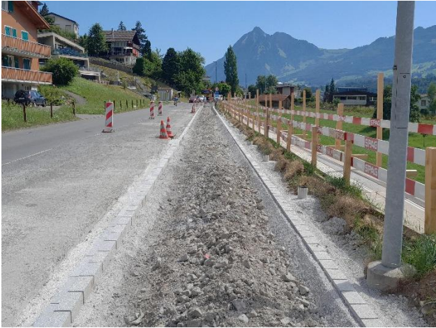
Neu eingebaute Randsteine Wilerstrasse
