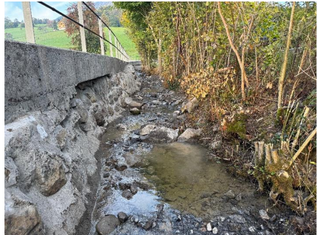
Chli Schlierli: Fertiges Gerinne und Mörtelfugen erneuert
