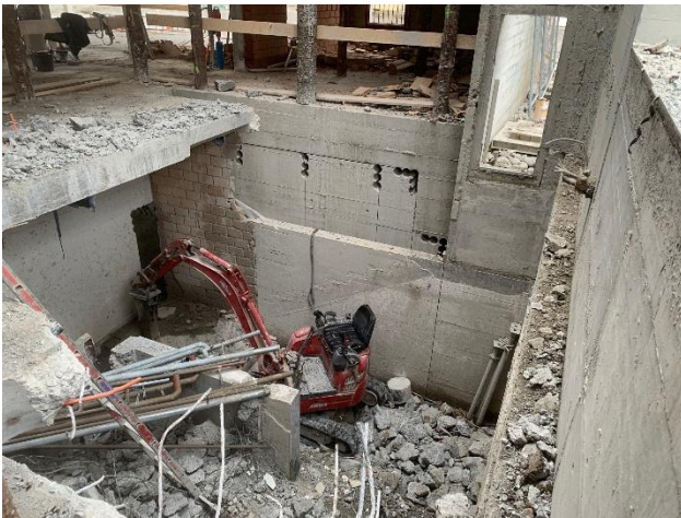
Rückbau alter Treppenhaukern Gemeindehaus
