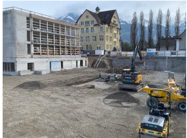
Fertiggestellte Baugrube
