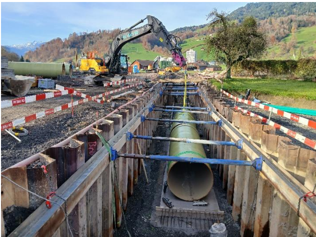
Erste Meter des neu eingebauten Staukanals
