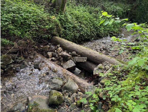
Steinhaltengraben: Holzsperrre ausgespült
