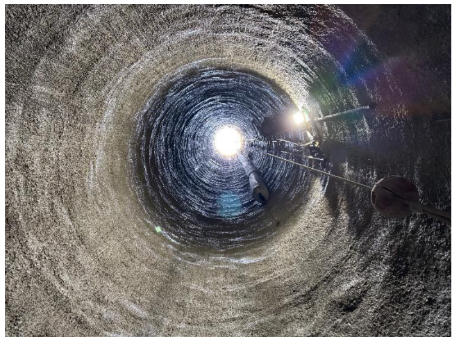
Kernmattbach: Blick aus 57 m Tiefe ans Tageslicht
