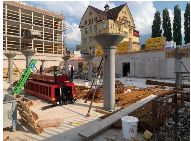
Erstellung Tiefgarage und UG Multifunktionsgebäude
