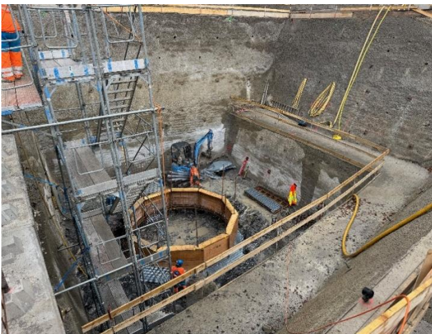
Kernmattbach: Start Abteufen Wirbelfallschacht
