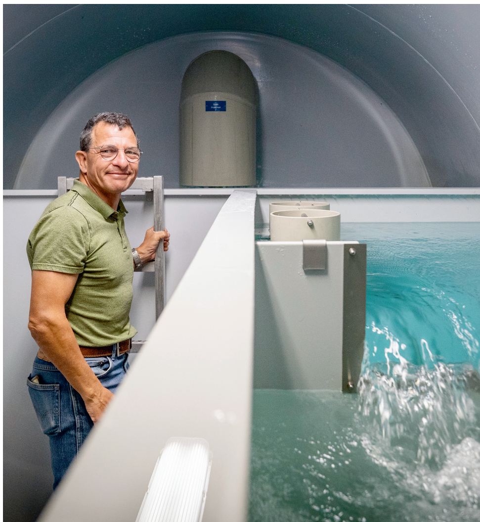
Leo Zberg, Leiter der Wasserversorgung Sarnen, in der unterirdischen Brunnenstube im Gebiet Gubermatt oberhalb Stalden. Hier sammelt sich das Quellwasser, bevor es weiter Richtung Reservoir fliesst. (Bild von ...)
