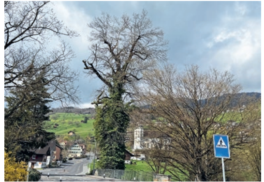
31. März 2025: Sicherheitsentlastungsschnitt an Hauptast ausgeführt
