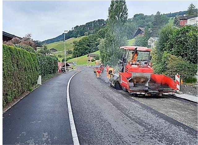
Einbau der Tragschicht bei der Wilerstrasse
