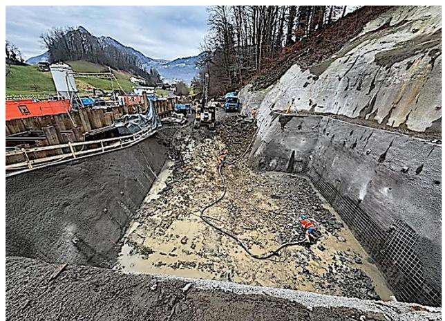
HWS Kernmattbach: Abteufen Baugrube und Sicherungsarbeiten
