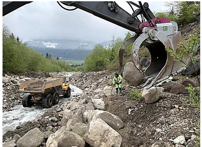
Steinibach: Versetzen Blocksatz in Hinterbeton
