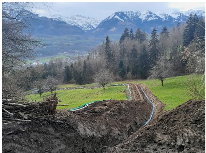
Leitungsbau Schwandi bis Heiligkreuz
