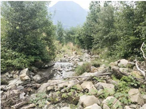
Mirgg: Rückhalteraum mit grossen Geschiebemengen. Das Geschiebe, wurde aus der Steilstrecke nach unten verlagert.
