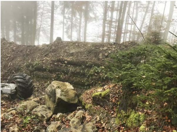
Einmündung Leitibach in den Steinhaltengraben, Allmend: Verfaultes Holzleitwerk.
