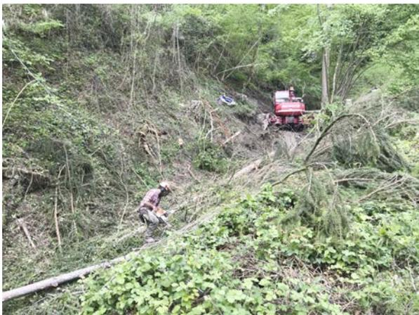
Eggeligraben, Eggeli: Holzerei vor Ort. Danach direkte Verwendung für den Einbau der einfachen Holzsperrn.
