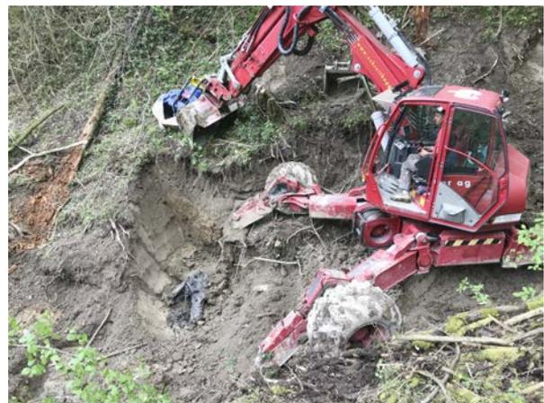
Eggeligraben, Eggeli: Aushub für den Einbau einer einfachen Holzsperrn (Holzsperrn dienen als Geschieberückhalt und Böschungssicherung).
