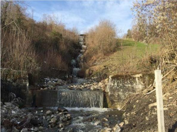
Bösendorf - Grüebel und oberhalb Mirgg: Die Steilstrecke mit den gekippten, verschobenen und teilweise zerstörten Betonsperrern.
