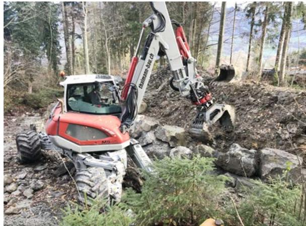
Einmündung Leitibach in den Steinhaltengraben, Allmend: Ersetzt wurde das Holzleitwerk durch einen Uferblocksatz, bei dem die untersten Steinreihen im Beton versetzt wurden.
