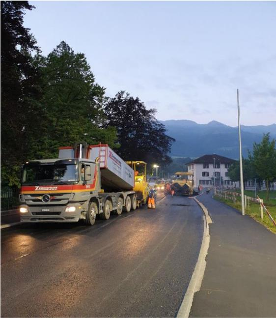
Belageinbau mit zwei Fertiger während Totalsperrung
