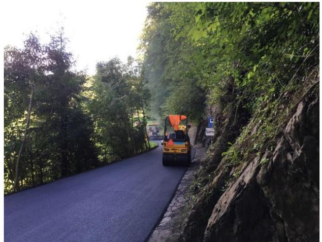
Verdichten der Fahrbahn mit Walzen
