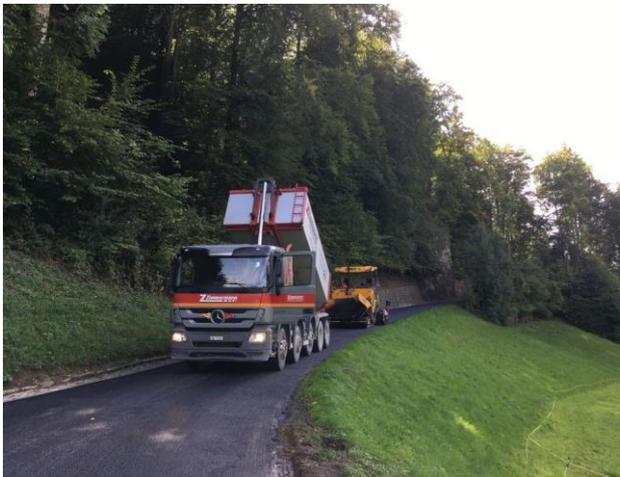
Belagseinbau mit Belagsfertiger
