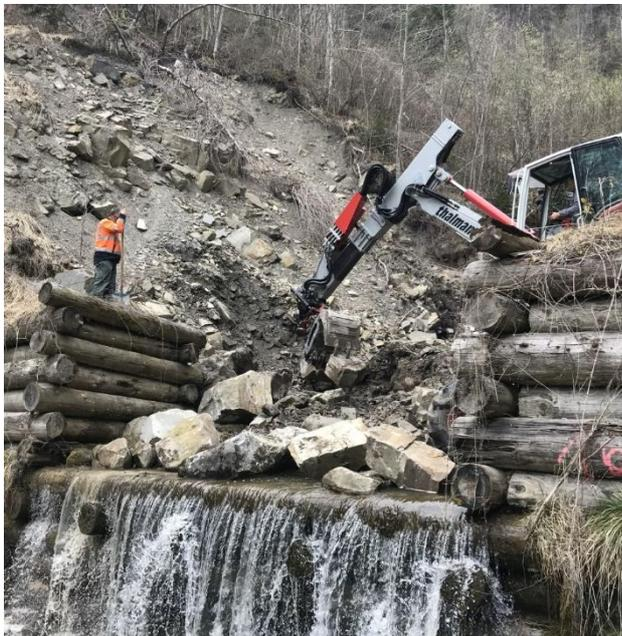
Schwandbach: Bau Blocksteinmauer im Ruffi
