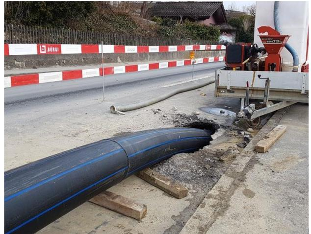
Einzug Schutzrohr für neue Wasserleitung
