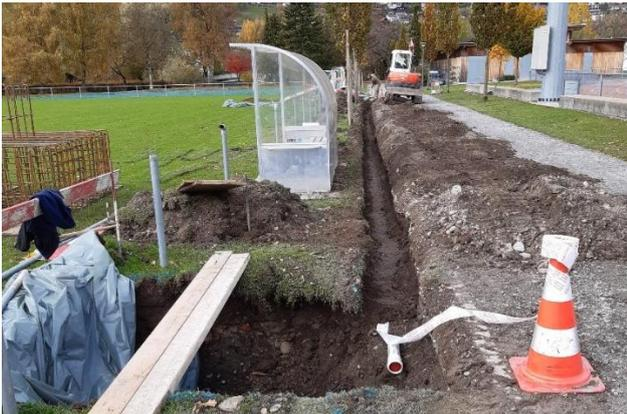
Grabarbeiten neue Rohr- und Kabelanlage
