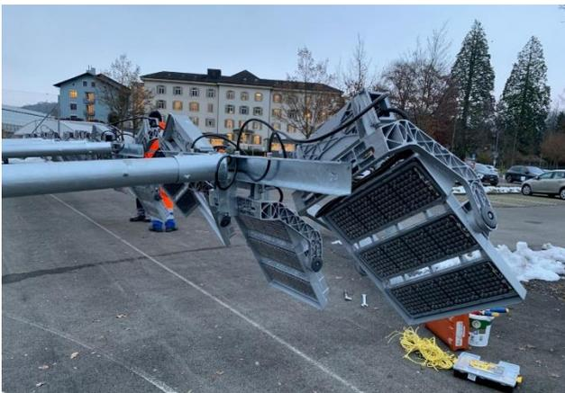
Vormontage der neuen LED-Strahler an die Masten
