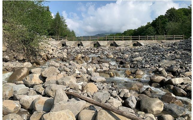
Steinibach April 2023: Sohlensicherungsarbeiten ausgeführt
