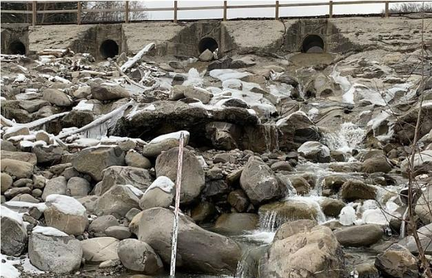
Steinibach Januar 2023: Erosierte Sohle
