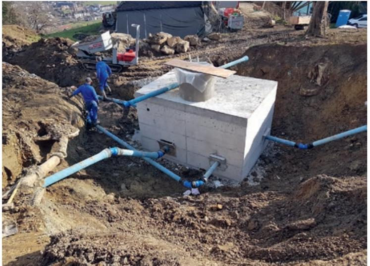
Druckreduzierventilschacht «Breitholz»: Druckverminderung von 22 bar auf 8 bar
