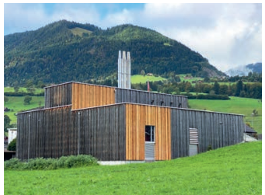
Gesamtansicht von Nordost (Foto: Hampi Lussi)
