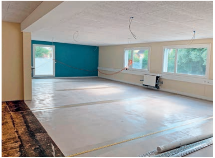
Ausbau eines neuen Kindergartenzimmers
