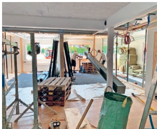
Bauarbeiten im neuen Foyer
