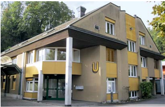
Merzweckanlage Ei vor Baubeginn
