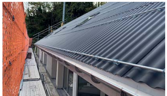
Fertig erstelltes Schrägdach
