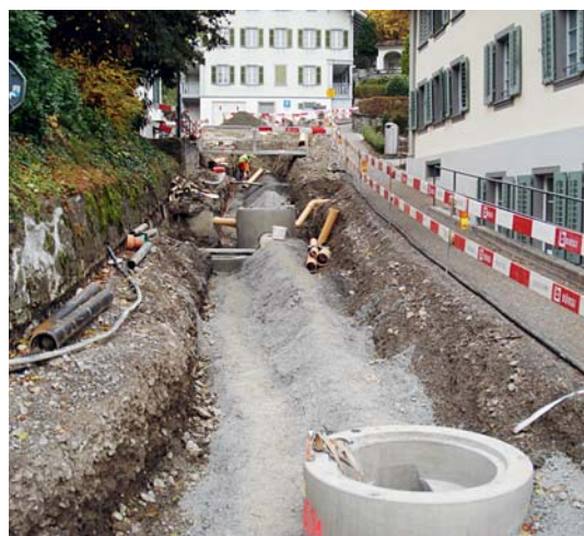
Situation Bergstrasse, entlang Peterhof: links: Grabenaushub für die neue Wasserleitung oben: Bau des neuen Entwässerungssystems
