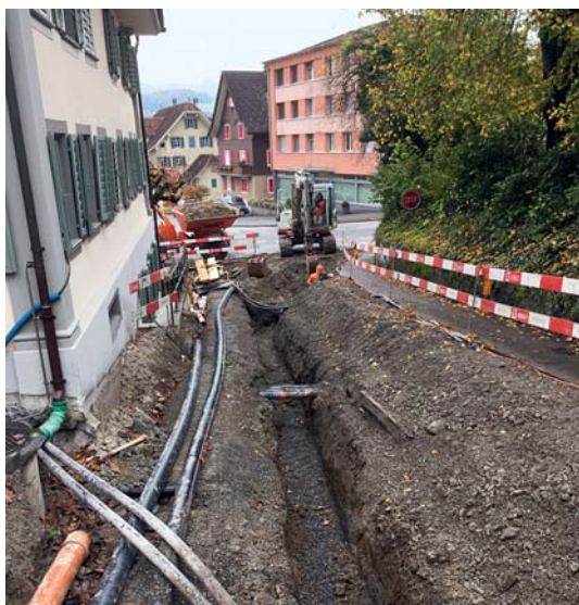
Situation Bergstrasse, entlang Peterhof: links: Grabenaushub für die neue Wasserleitung oben: Bau des neuen Entwässerungssystems
