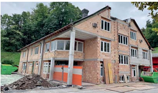
Rückbau Fassade inkl. äusseres Mauerwerk
