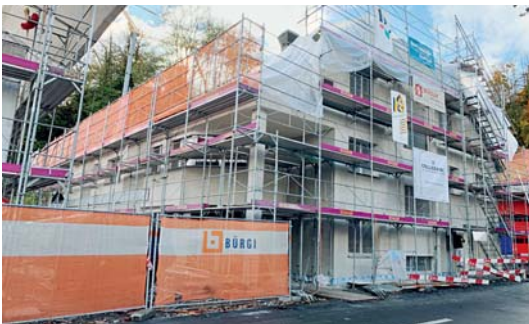
Aufbau neue Fassade
